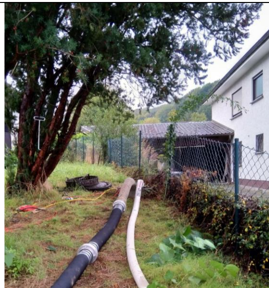
Löschwasserentnahme über Saugschacht
